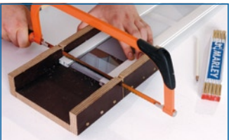
Zuschneiden der Profile auf die benötigte Länge.
